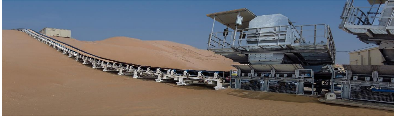
سیستم انتقال مواد توسط نوارهای نقاله در سیستم IPCC شرکت MCI
